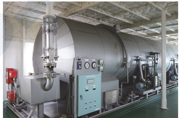
図5 船舶用CO2消火装置 (-17℃・2.1MPa)
