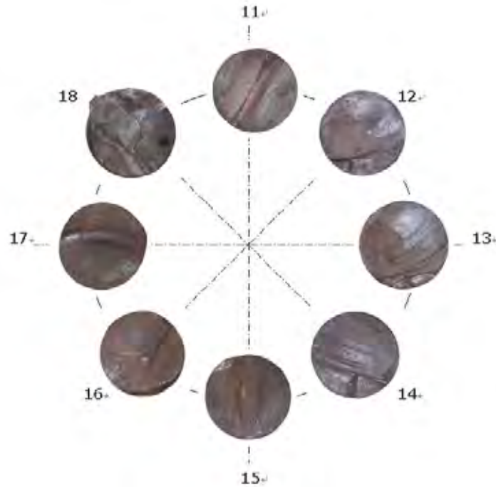
図 3.3.5 き裂の進展方向（船尾側から見る）
