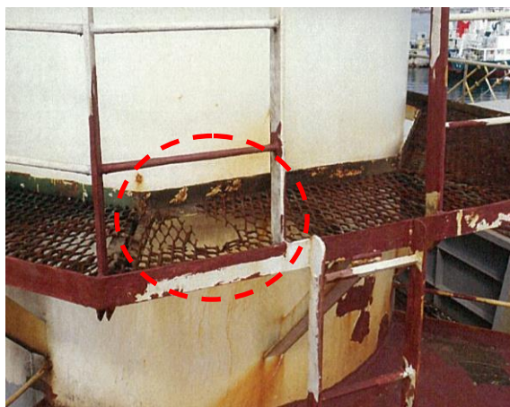
← キャットウォークの破損
