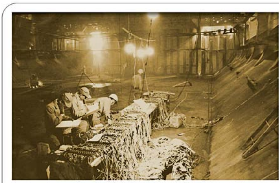
昭和39年（1964）貨物船の二重底構造の実船試験
